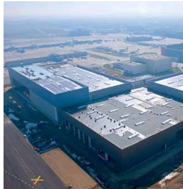
Das A350-XWB-Gebäude ist mit Solarkollektoren ausgestattet.
